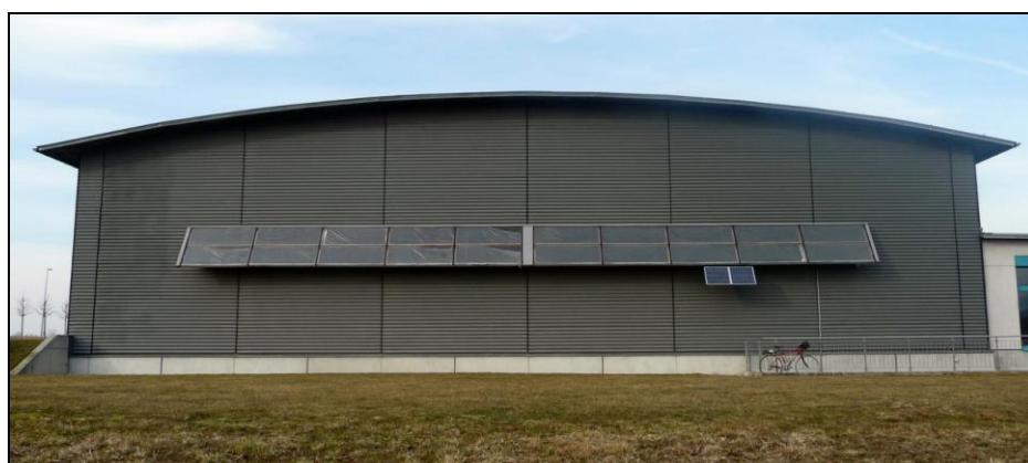
Abbildungen 51 - 53: Einige Sensler Sportgebäude sind mit einer solarthermischen Anlage ausgestattet. Im Bild sind die Sportgebäude in Plasselb, Heitenried und Wünnewil. Photos: M. Gutschner
