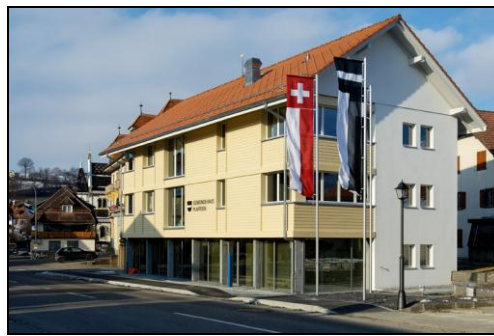
Verwaltungsgebäude (EBF 557 m 2 ) in Plaffeien
