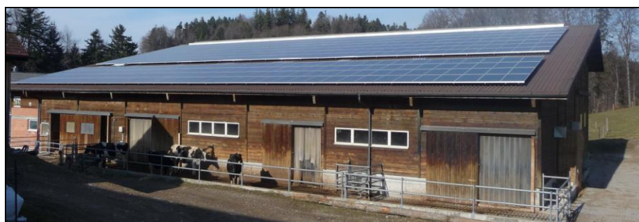
Abbildung 69: Mit einer Leistung von 85,7 kW steht in Ober Beniwil (Alterswil) die zweitgrösste Sensler Photovoltaikanlage (Stand Ende 2010). Photo: M. Gutschner
