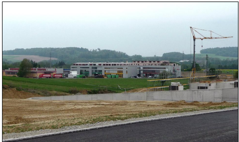
Abbildung 78: Die Industriezone in Düringen ist für den Kanton und auch für die energetische Nutzung von strategischer Bedeutung. Im Bild die Arbeiten in der prioritären Erweiterungszone beim Autobahnanschluss. Photo: M. Gutschner
