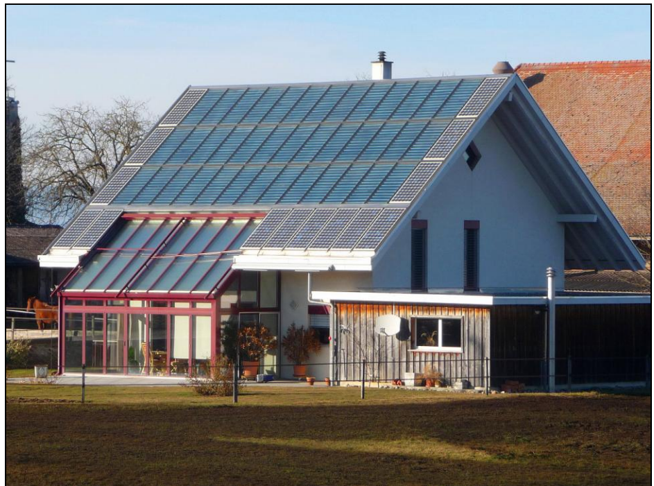
Abbildung 89: Das Sonnenhaus in Uttewil (Bösingen) wird schon seit über zehn Jahren 100% solar beheizt. Photo: M. Gutschner
