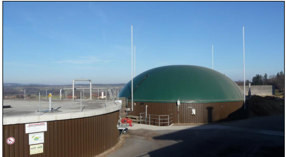
Abbildung 75: In Uttewil (Bösinggen) steht bereits seit 1979 eine landwirtschaftliche Biogasanlage. Die sanierte und vergrösserte Anlage produziert jährlich 1,4 GWh Strom. Die Abwärme wird für den Fermenter und Nachgärer sowie zur Beheizung von zwei Wohngebäuden, Warmwasser und Schweinestall benutzt. Photo: M. Gutschner
