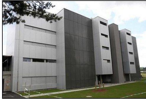
Schulgebäude (EBF 6'575 m 2 ) in Düdingen
