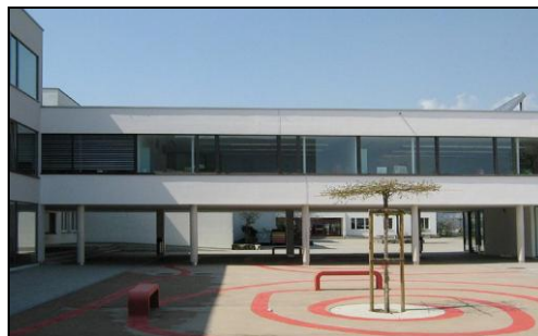
Schulgebäude (EBF 1'348 m 2 ) in Wünnewil
