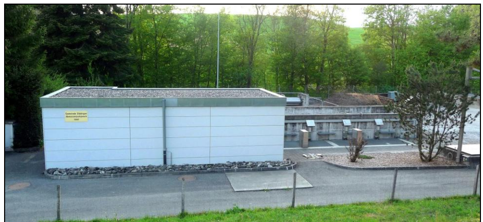
Abbildung 107: Das technische Nutzwärmepotenzial im Abwasserpumpwerk (ehemals Kläranlage) Santi-Hans in Düdingen wird auf maximal 0,7 GWh geschätzt, doch die Wirtschaftlichkeit ist derzeit eher ungünstig. Photo: M. Gutschner
