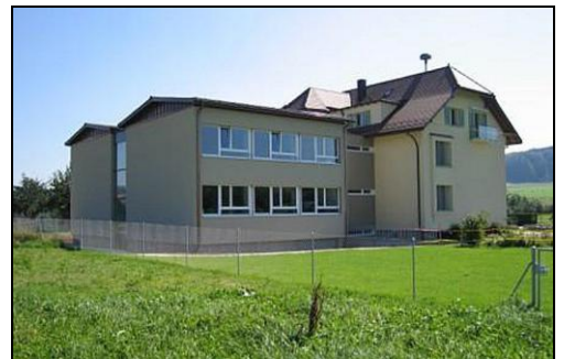
Schulgebäude (EBF 856 m 2 ) in St. Ursen
