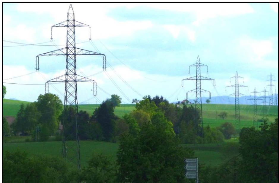
Abbildungen 81 + 82 Die steigende Anzahl dezentral Strom produzierender Anlagen (im oberen Bild die Photovoltaikanlage in Ziegelhus, Gemeinde Alterswill, mit rund 60 kW Leistung) und Energieversorgungssicherheit stellen hohe Ansprüche ans Elektrizitätsnetz (im unteren Bild die Hochspannungsleitung beim Steinler (Düdingen)). Photos: M. Gutschner
