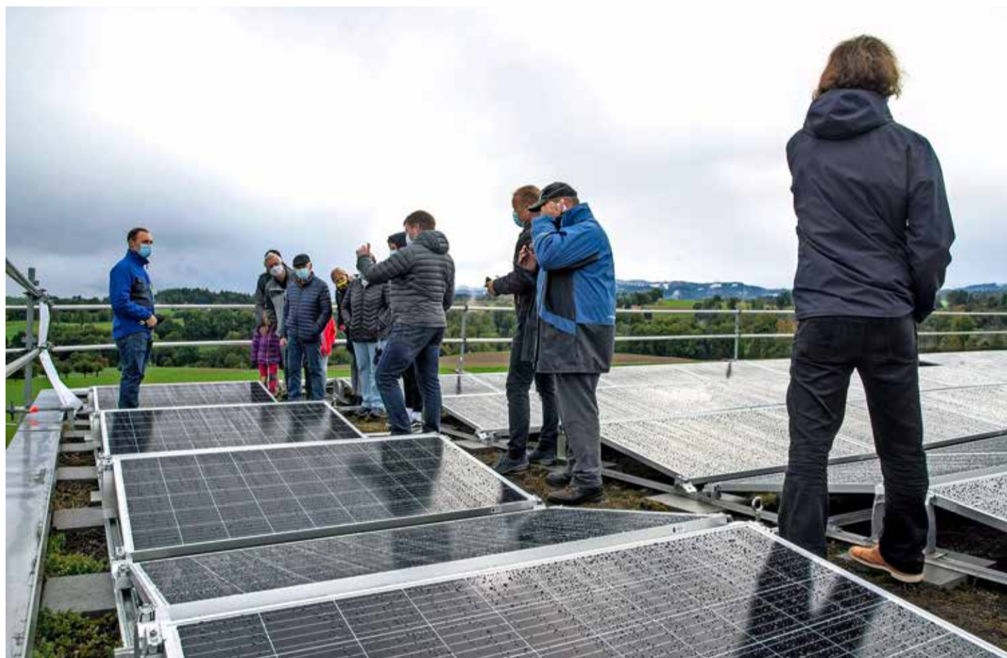
Die neue Fotovoltaikanlage auf der OS Wünnewil ist eröffnet.
